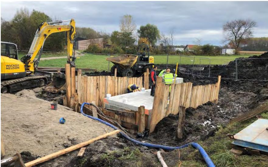
Auf Drängen der Gemeinde Moosbrunn errichtet die EVN Wasser eine zweite Einspeisestelle in unser Ortswassernetz. Dieser Anschlusschacht wird gerade im Bereich zwischen Schillingerwiese und Neubach installiert und in Betrieb genommen. Wir erwarten uns dadurch weniger Druckschwankungen in der gesamten Ortswasserleitung und eine Erhöhung der Ausfallsicherheit. Vor allem die Löschwasserversorgung bei Einsätzen unserer Feuerwehr soll dadurch deutlich verbessert werden.
