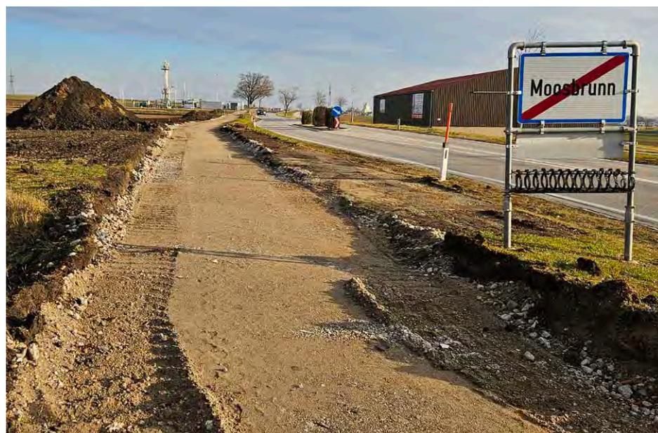
Der Unterbau des Radweges wurde bereits fertiggestellt und kann sich nun über den Winter setzen. Sobald die Wetterbedingungen es zulassen, wird die Asphalt-schicht aufgebracht. Nach Abschluss der Arbeiten wird der Radweg allen Rad- und Rollerfahrern sowie Spaziergängern zur Verfügung stehen. Dieses Projekt trägt wesentlich zur Verbesserung der Verkehrsbedingungen und zur Förderung umweltfreundlicher Mobilität in der Region bei.
